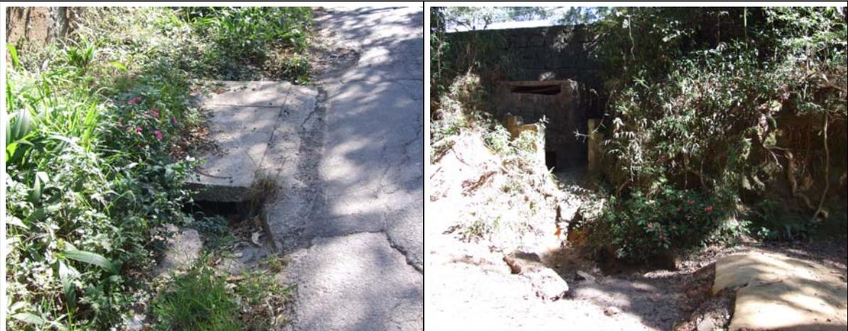
E 01 – Captação de água da Estrada da Roseira e lançamento na Trilha do Pinheirinho, provocando erosão em sulcos e ravinas.
