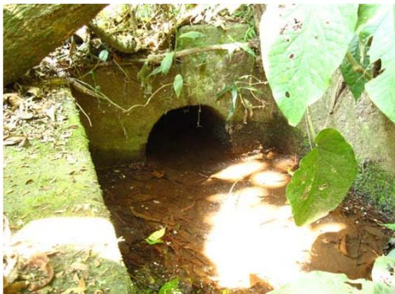
Foto 2007 aqueduto em alvenaria 500mm de diâmetro
