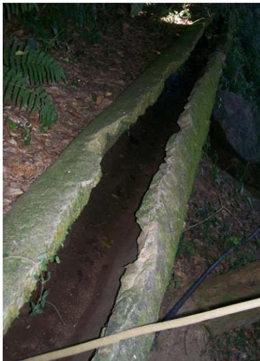
Aqueduto com diâmetro de 600 mm – Foi retirada parte da estrutura superior julho 2008
