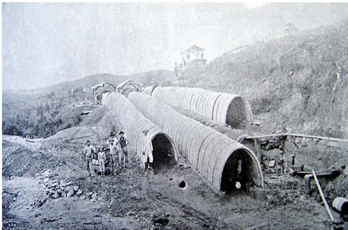
Abobadas de cimento armado para o aqueduto em tunel
